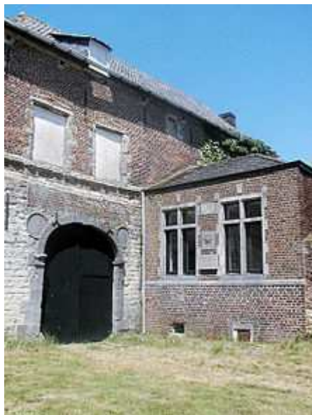
Le portail sud de la ferme
